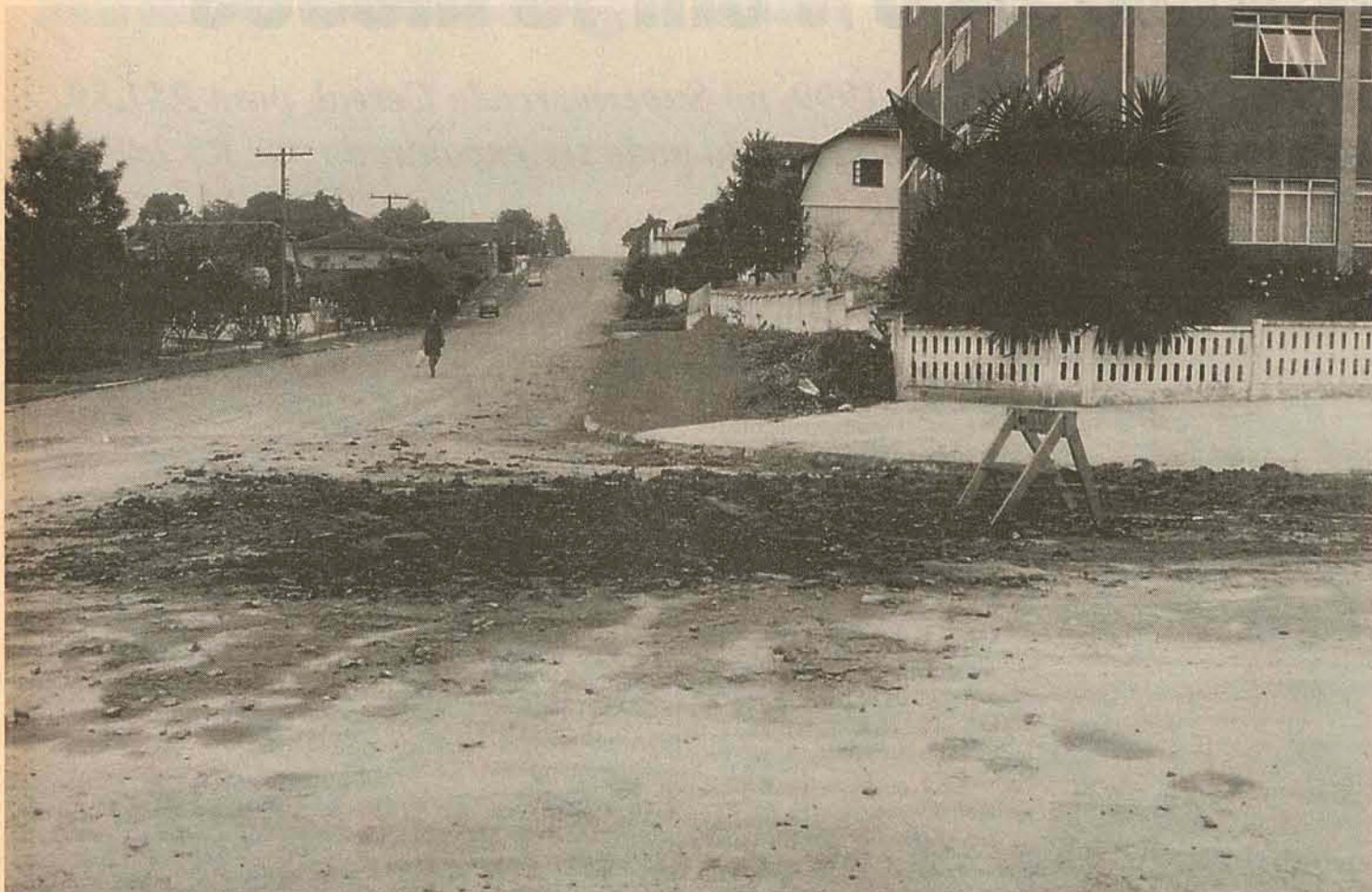
Buracos nas ruas abertos pela Casan deverão ser consertados pela própria empresa dentro de 60 dias
