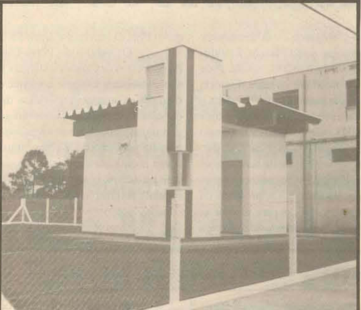
Instalações do Posto Telefônico, que breve será inaugurado
