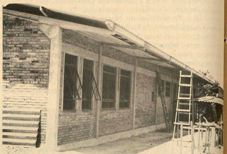
Ampliação do prédio da UnC em Canoinhas. FOTO: Fernando Tokarski.
