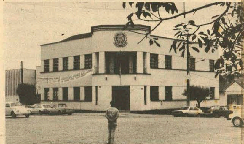
A Câmara de Vereadores eleita neste pleito, já começará o mandato de casa nova, nas dependências da nova prefeitura.
