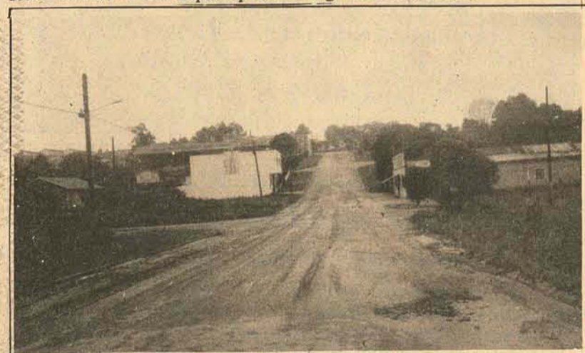
O asfalto da rua 12 de Setembro transformou-se num lamaçal.
