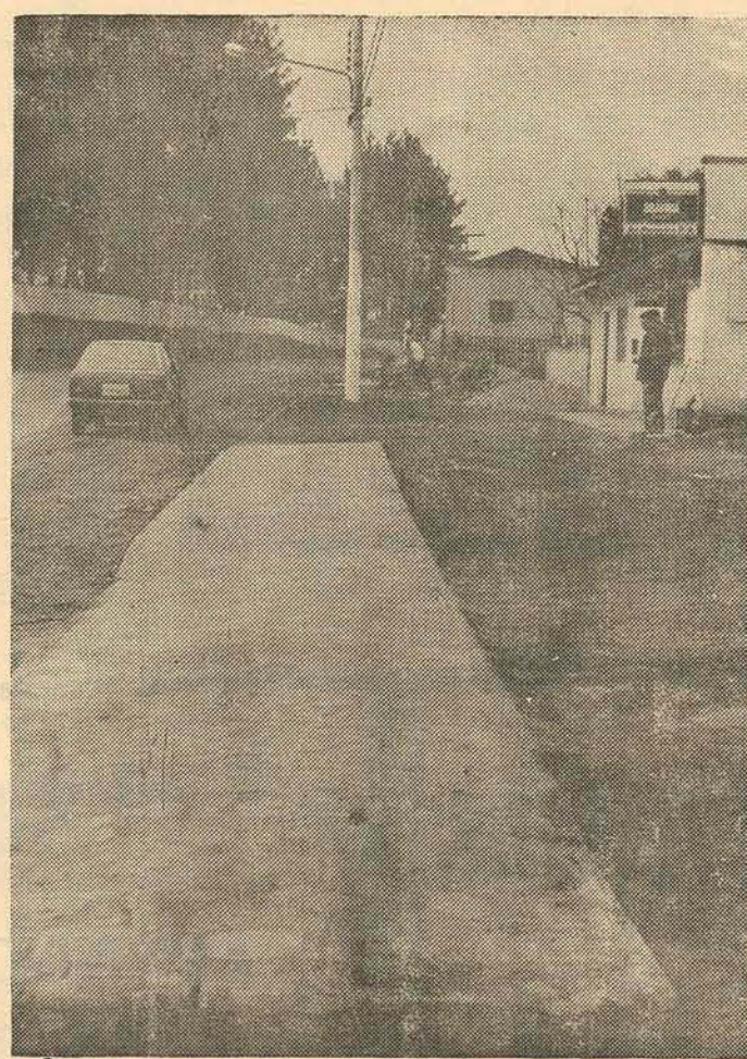
Passeio para pedestres na Av. Rigesa, proporcionando segurança.
