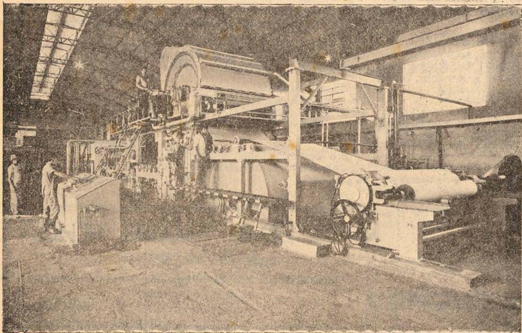
A MÁQUINA QUE ENTROU EM OPERAÇÃO ESTE MÊS TEM A CAPACIDADE PARA PRODUZIR 18 TONELADAS/DIA DE PAPEL HIGIÊNICO EM BOBINAS JUMBO DE 260 KILOS CADA UMA.
