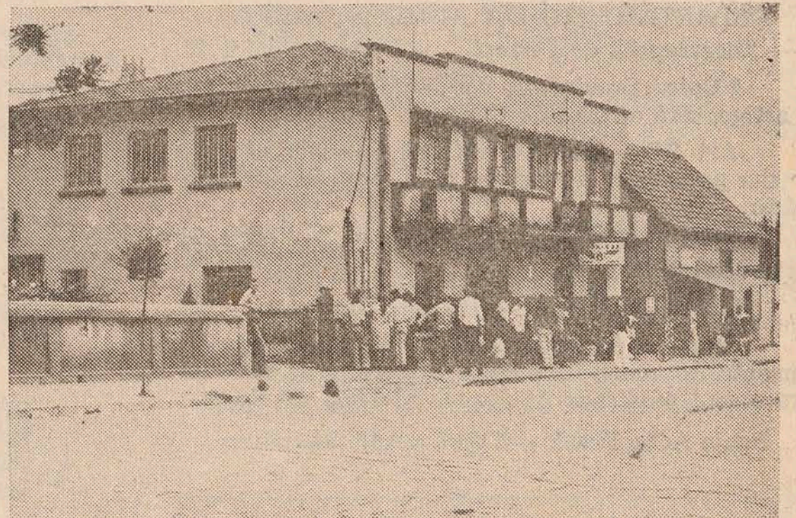
Atual Terminal Rodoviário, Interestadual e Intermunicipal, localizado na Rua Vidal Ramos, no Centro da Cidade.
