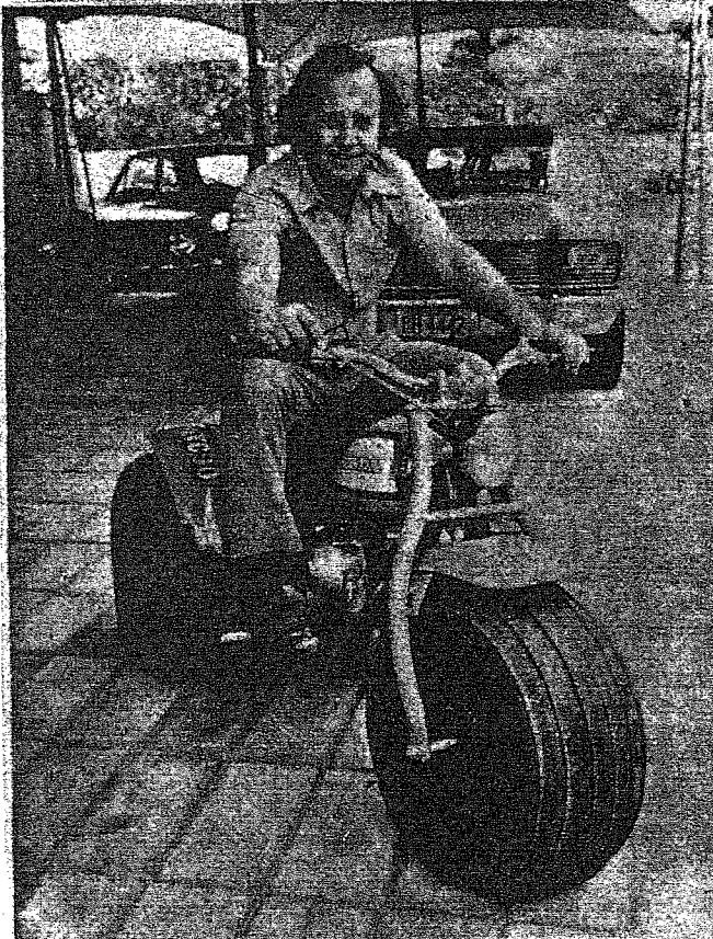
O triciclo tem um motor de 4 tempos e 90 cilindradas.
