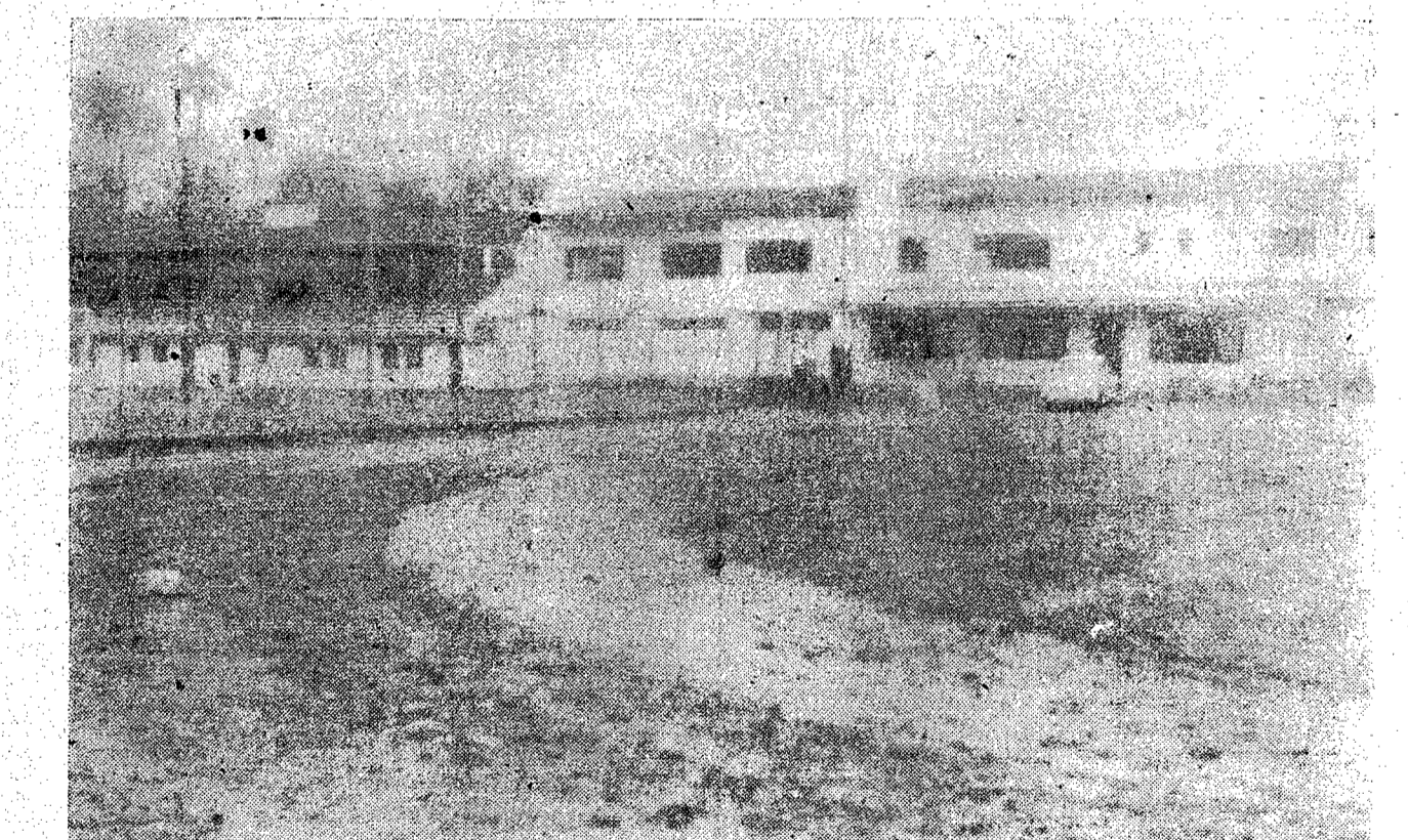
Aspecto atual do novo restaurante, instala do no estádio Dr. Aderbal Ramos da Silva.
