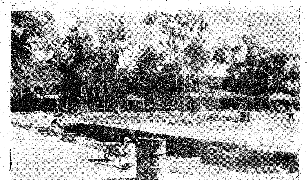
Assim começaram as obras do Ginásio do Vasto Verde.
