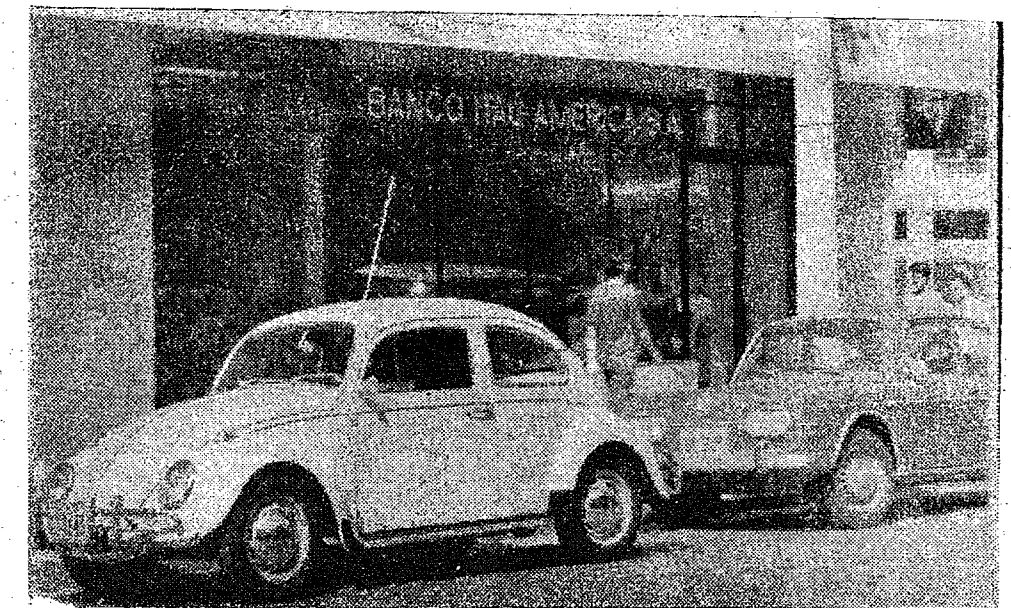
Neste prédio, localizado na Rua 15 de Novembro funcionará a Agência do Banco Itaú América. A inauguração será no dia 22 do corrente, cabendo ao Sr. Mário Bernardes da Silva a Gerência do estabelecimento bancário.
