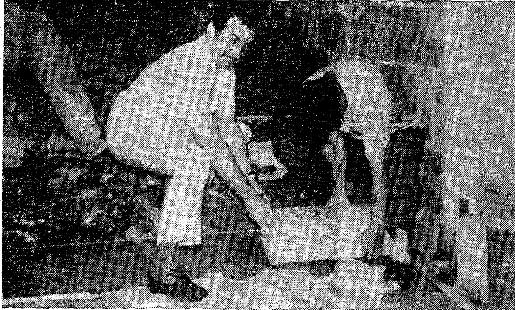
No flagrante acima, vemos o Sr. Carlos Cid Benaux, Presidente da Federação das Indústrias de Santa Catarina, quando no dia de ontem, colocava a primeira pedra, do primeiro degrau, da Igreja Mãez de Brusque. Os trabalhos terão continuidade ininterruptamente até a conclusão, quando então aquece templo, estará mais embelezado ainda.
