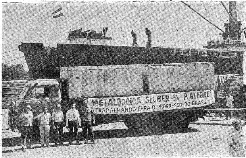
A foto registra a descarga de mais duas máquinas conformadoras rápidas a frio, para fabricação de porcas, encomendadas há 18 meses nos EUA, com a capacidade produtiva por máquina de 140 peças por minuto. O equipamento em referência, o mais moderno existente no mercado internacional, faz parte da primeira etapa do plano de expansão integralmente aprovado, conforme resoluções nºs 66 - 452 - 480 e 540 do Grupo Executivo da Indústria Automotora (GEIMOT).
