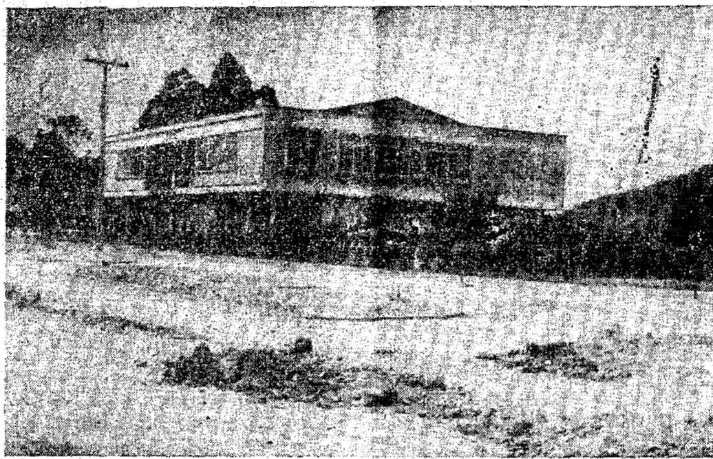
Aspecto do novo prédio da Prefeitura e Forum da Comarca do Município de Pomerode, inaugurada recentemente pelo Governador do Estado, Dr Ivo Silveira.
