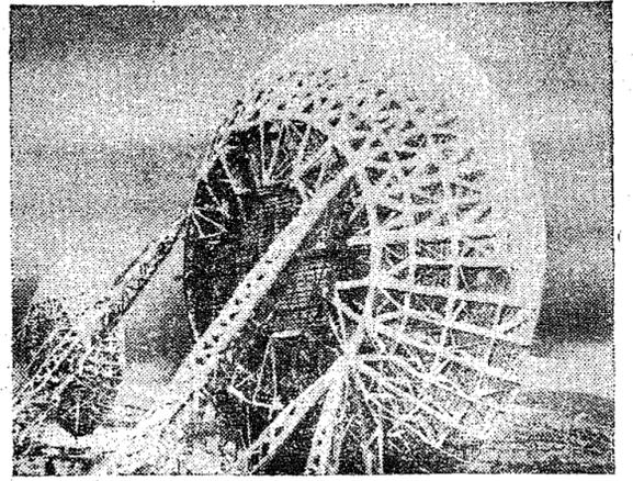
Estas antenas parabólicas de alumínio, de 18 metros de diâmetro, formam uma das muitas séries de instalações para comunicações no perímetro defensivo do Alasca.
