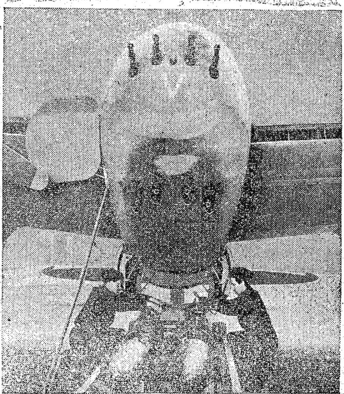
O Novo Tipo Bombardeiro - Caça "Mosquito" da R.A.F. - Içando as bombas para a fuselagem do novo bombardeiro-caça "Mosquite" da R.A.F. Seus ferrões podem ser vistos bem na ponta de seu nariz.
