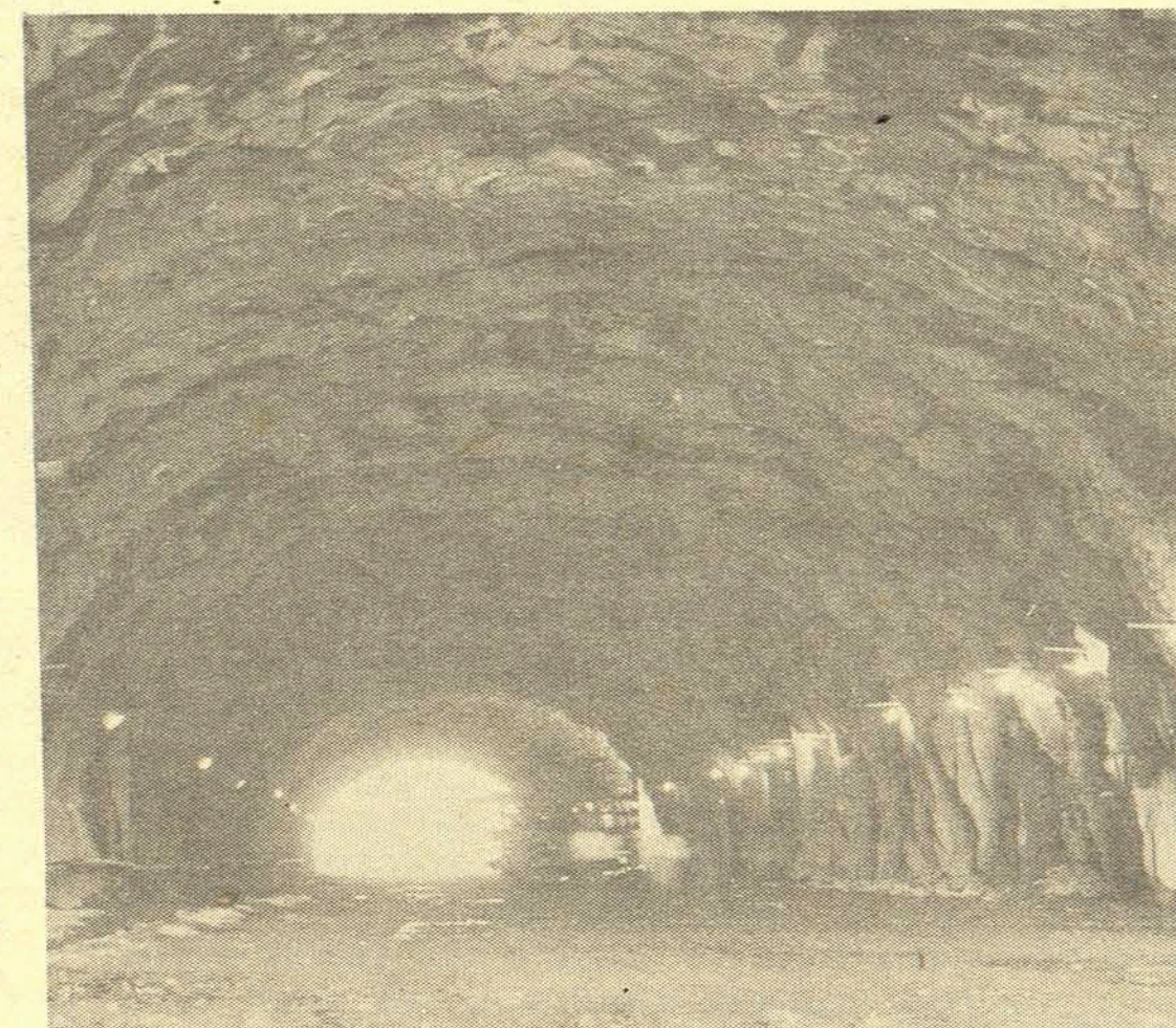
Este é um dos quatro túneis para o desvio do rio, onde, em abril, foi quebrado o recorde nacional de escavação em rocha.
