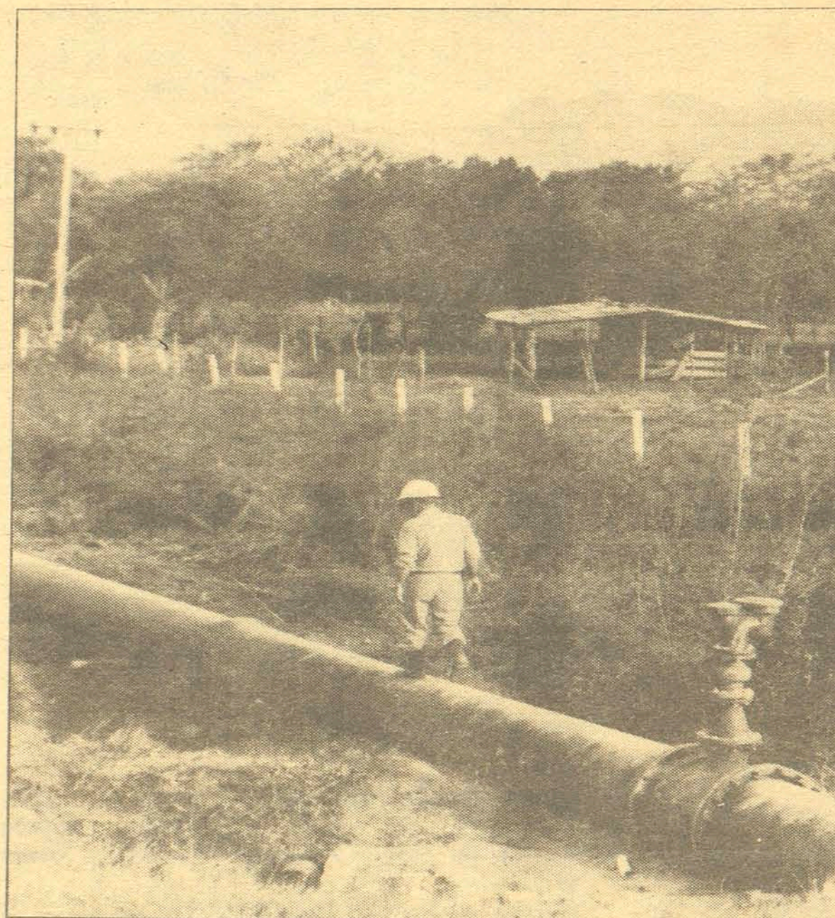
Tubulação de ferro avança rumo ao Morro do Esquadro
