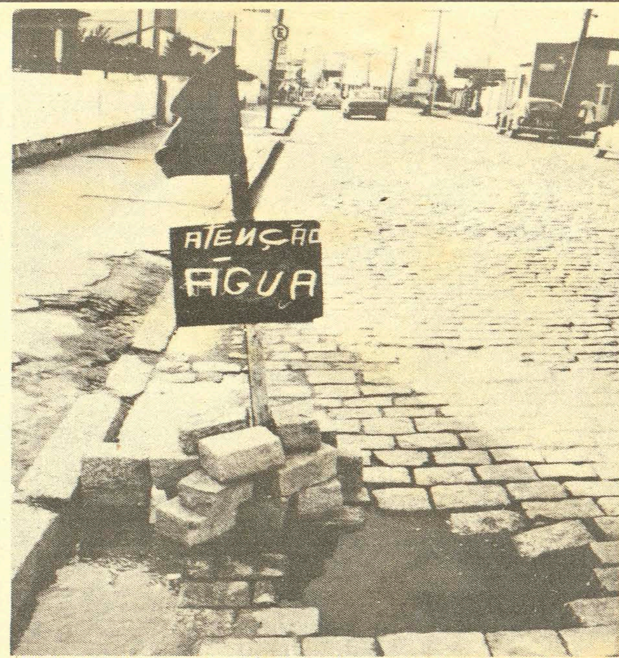
Falta água nas torneiras, sobra na rua. Um milagre?
