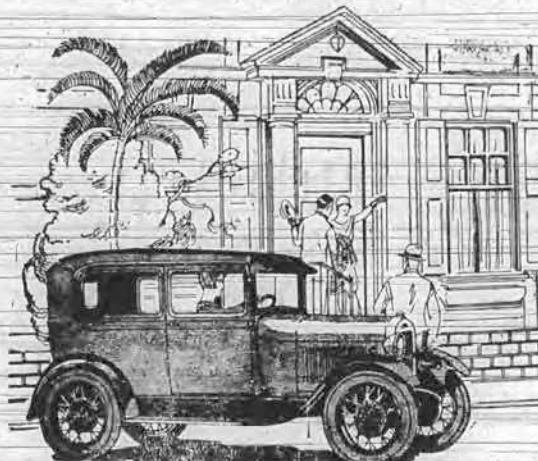
Este carro reúne todos os características dos novos carros Ford: gracioso conjunto de linhas, e cores variadas; vidro de parabrisa triplo; mais de 100 quilometros por hora; motor de 40 H.P.; notável aceleração; amortecedores de choque hidráulicos; freios nas quatro rodas; segurança e durabilidade típica da Ford; de custo inicial reduzido e conservação econômica.
