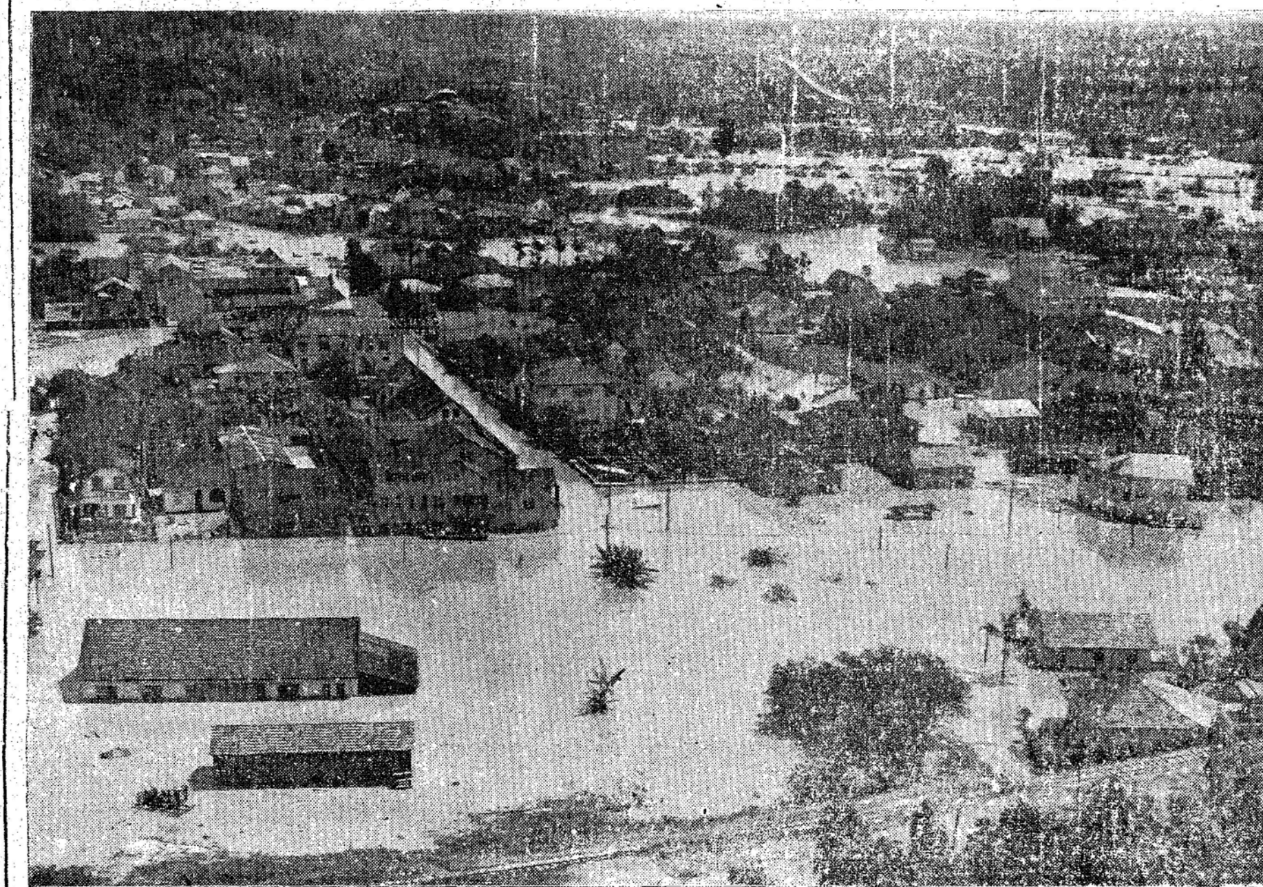
A foto acima, tirada da estação de tratamento de água, mostra um trecho da Rua São Paulo, Rua Paraíba e, no fundo, no bairro da Velha, assinaladas pela flexa, diversas casas só com os telhados de fora.
