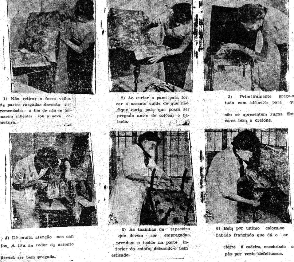
1) Não retirar o forro velho. As partes rasgadas deverão ser remendadas, a fim de não se tornarem salientes sob a nova cobertura.
