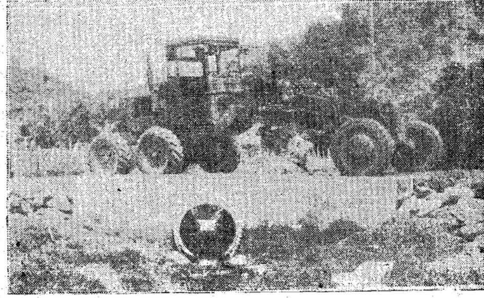
Construção de boeiro na Rua Antonio Zendon
