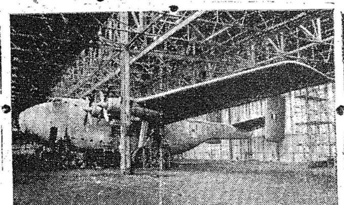
O mais moderno e maior avião de transporte britânico, em cuja fabricação se aproveitou toda a experiência das fabricações do tempo de guerra e que pode transportar cerca de 150 passageiros. O Transportador Universal, conforme o chamam seus fabricantes, de carregamento e descarregamento muito rápido e simples, está perfeitamente apto para o transporte de cargas grandes e pesadas, como ônibus e coisas semelhantes. (ENS).
