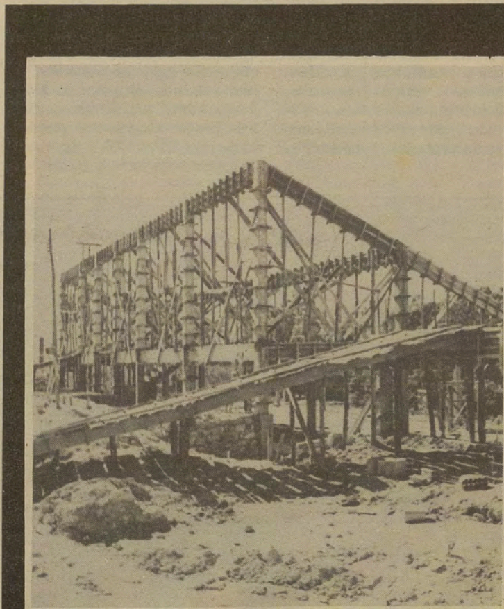
O atual estado das obras
