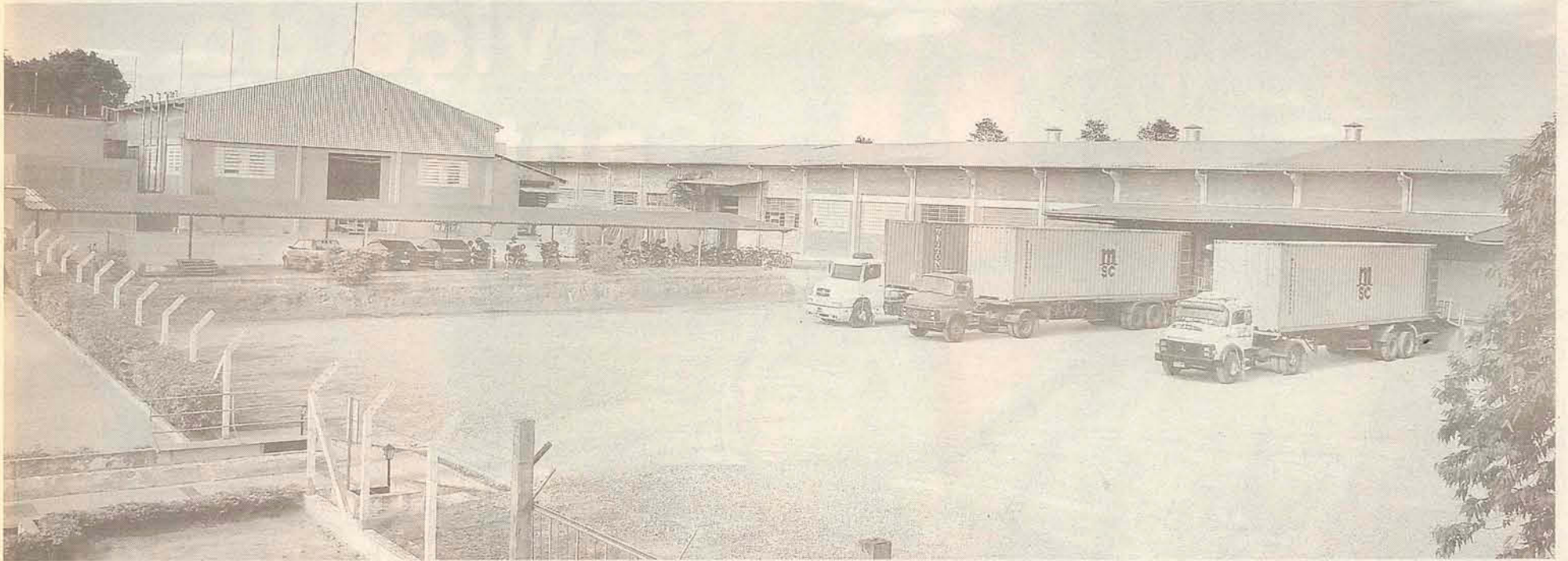
Parque industrial da empresa, localizado na Rodovia Ivo Silveira, no Santa Terezinha, gera 450 empregos diretos
