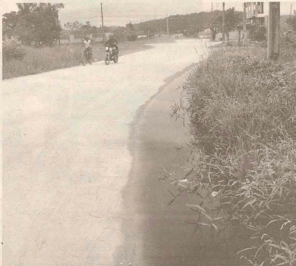
Além do mau cheiro, esgoto a céu aberto pode transmitir doenças
