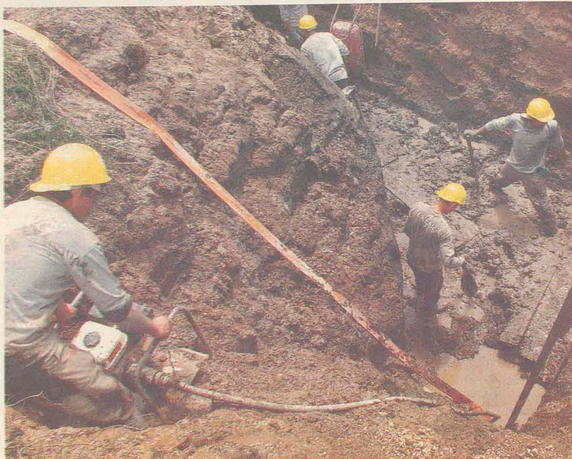
Serão colocados tubos de 1,60 m de diâmetro e a obra tem previsão de término em 30 dias
