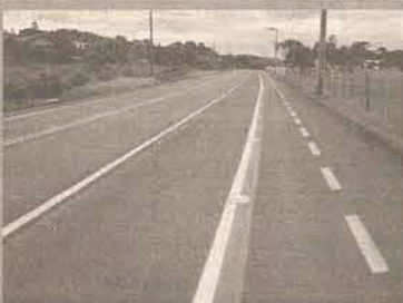
*Estrada da Madeira Pavimentação de 5,6 km ligando Lontras a Rio do Sul
