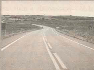
SC 451 Pavimentação de 30 km do acesso que liga Curitibaanos a Frei Rogério
