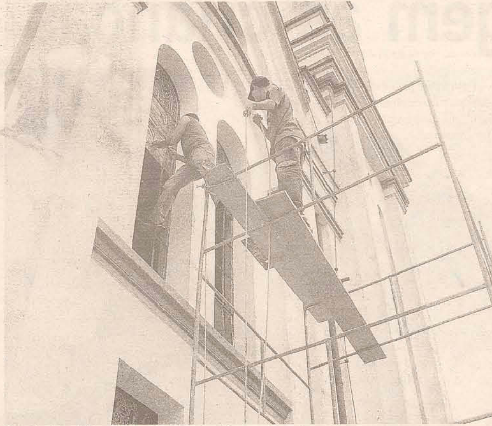
Os vitrais estão sendo retirados para limpeza e restauro
