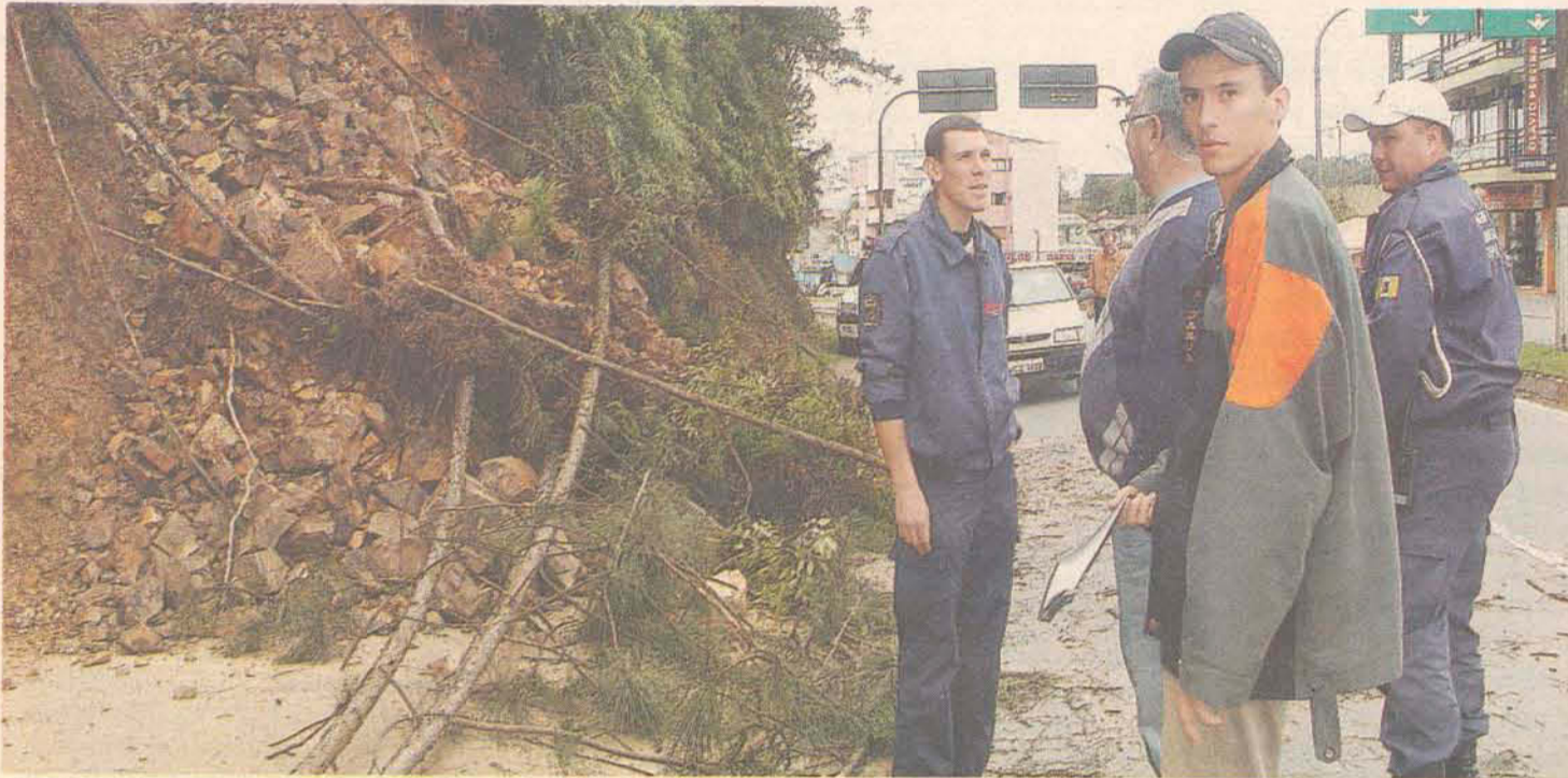
Barranco desmoronou na Avenida das Comunidades em frente ao posto de combustível
