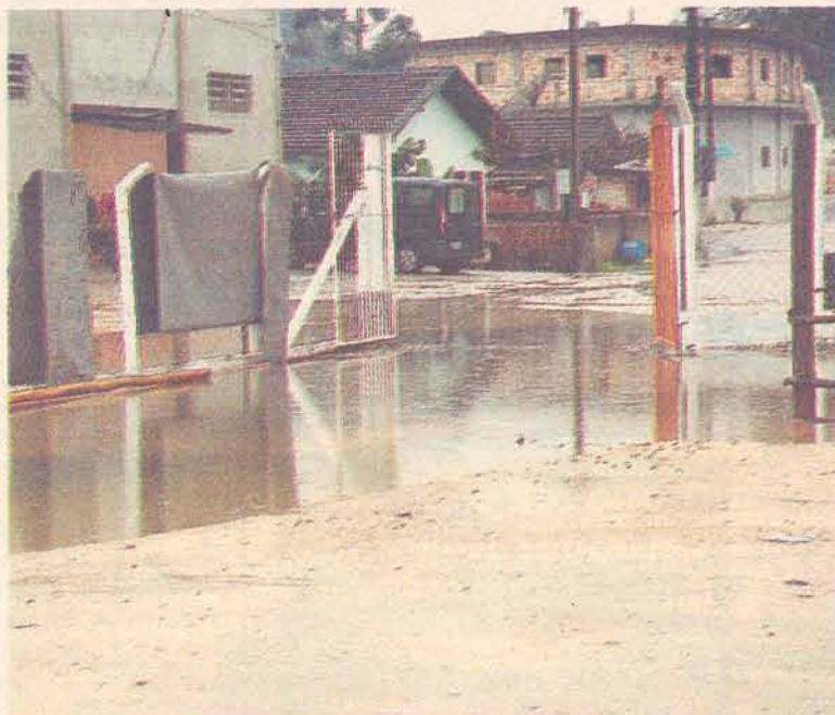
O portão de entrada estava tomado de água por falta de escoamento.
