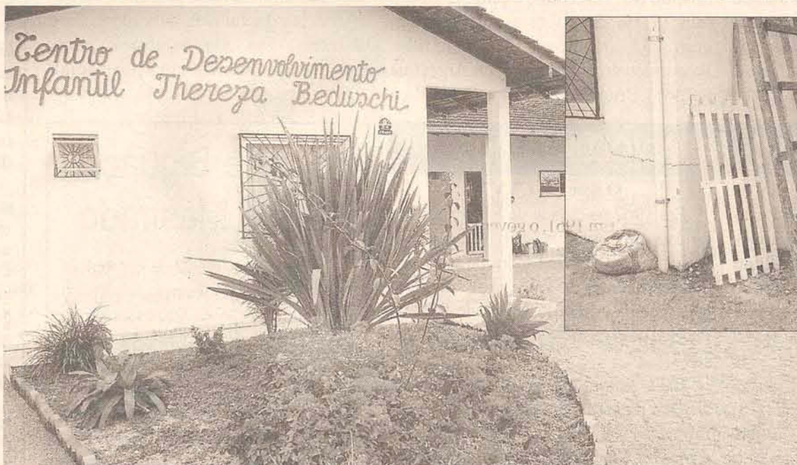
Rachaduras e fissuras sempre deixaram pais e funcionários apreensivos
