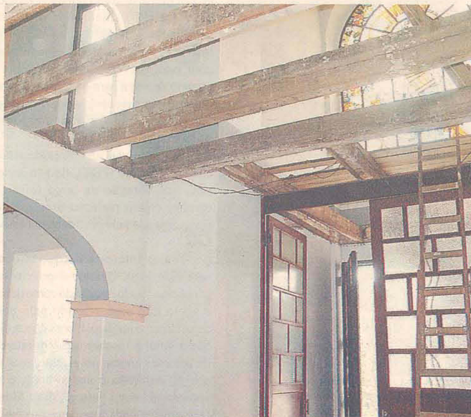
O coro que estava em situação precária está sendo todo restaurado
