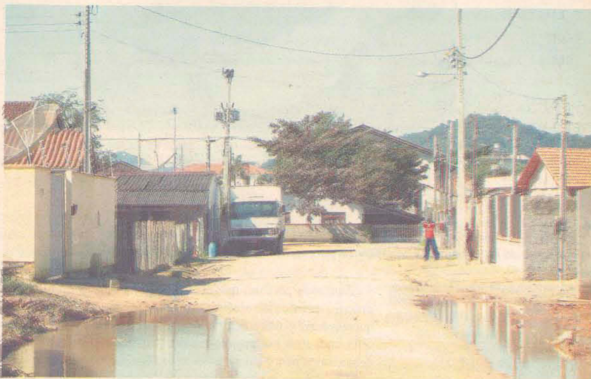
Falta de "bocas de lobo" não deixa que a água escoe
