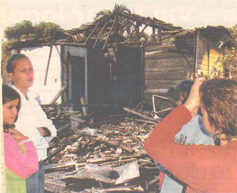
Vizinhos ficaram assustados com o incêndio
