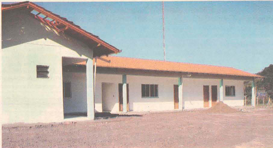
A obra foi paralisada faltando pouco para terminar
