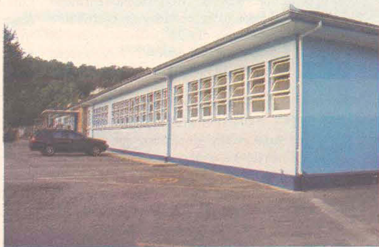
Iniciada a obra, o prazo de conclusão é de até 120 dias
