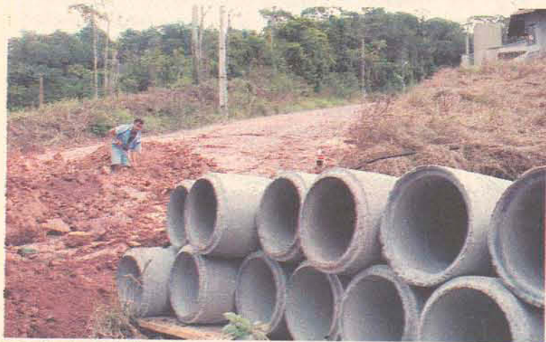
Tubulação já foi instalada na rua do novo acesso
