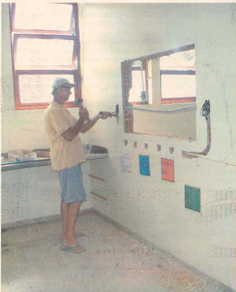
Paredes quebradas para adequar as salas para o atendimento
