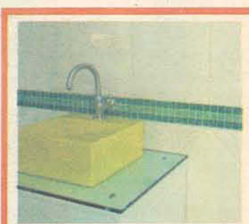
▲ Assentamento de pastilhas com argamassa auto fugante
