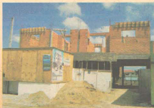
Andamento da Obra - 27/03/2007
