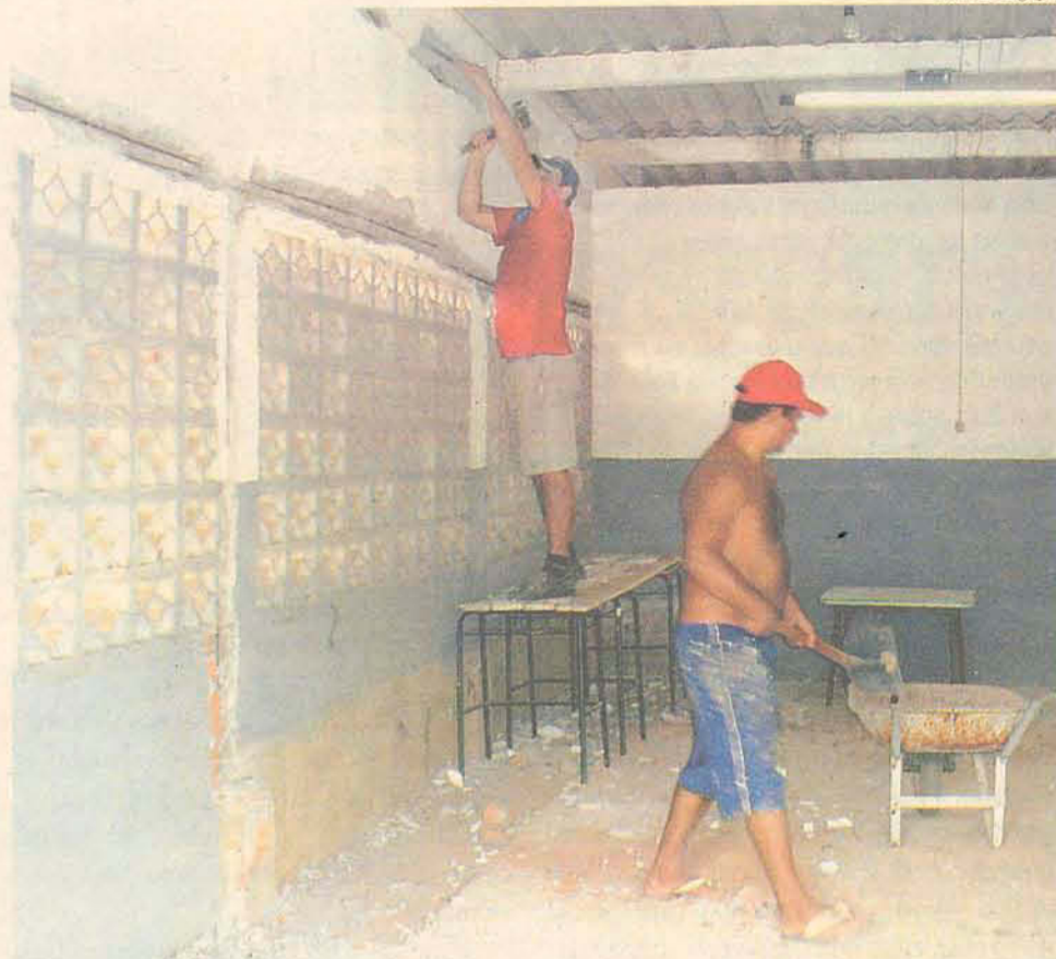
As obras para a reforma da creche começaram na terça-feira (13)
