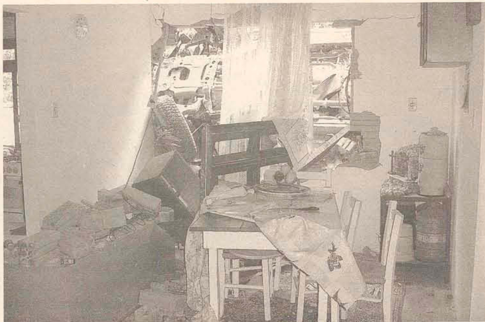
Toda estrutura da casa ficou comprometida pelo impacto.
