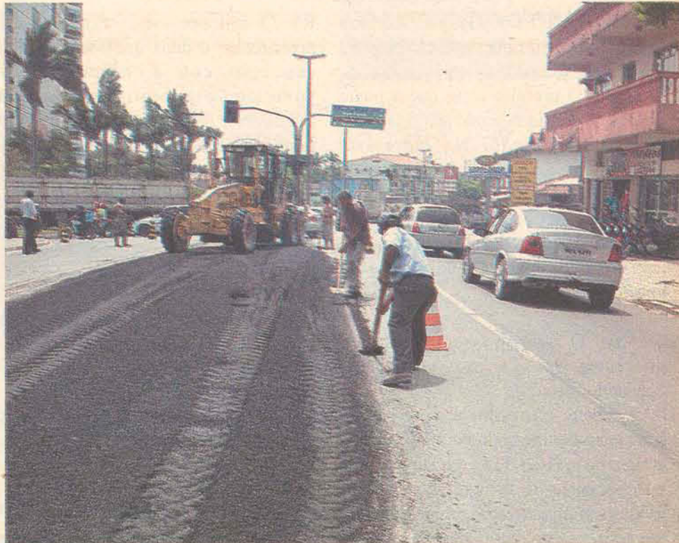
O asfalto foi colocado pela equipe do Ditran na última quinta-feira.
