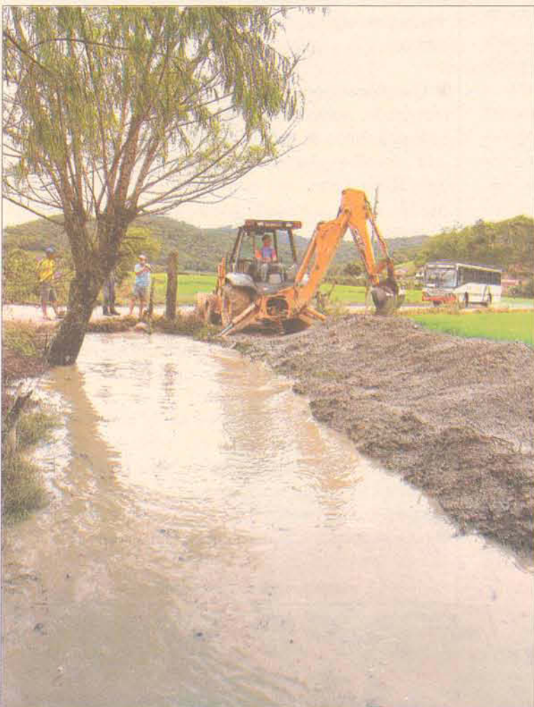
Ribeirão após o desassoreamento: problema não está solucionado
