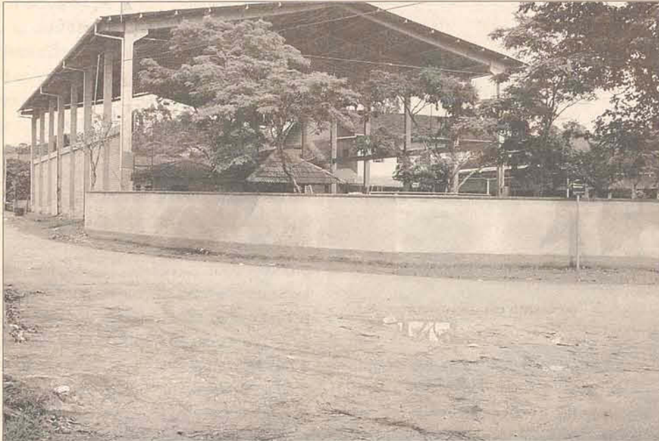
Muro da quadra da escola Luiz Franzói foi reformado
