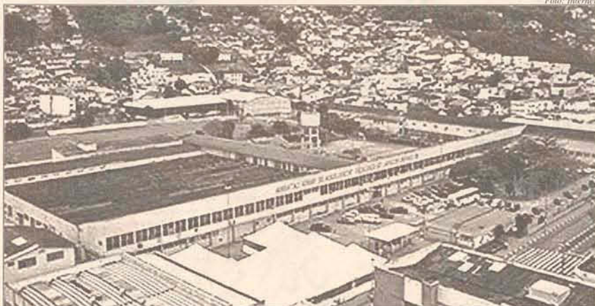
CEFET é uma das obras que deve ser executada em Gaspar
