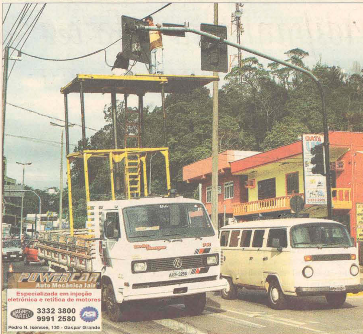
Equipes trabalharam durante a segunda-feira na troca dos semáforos
