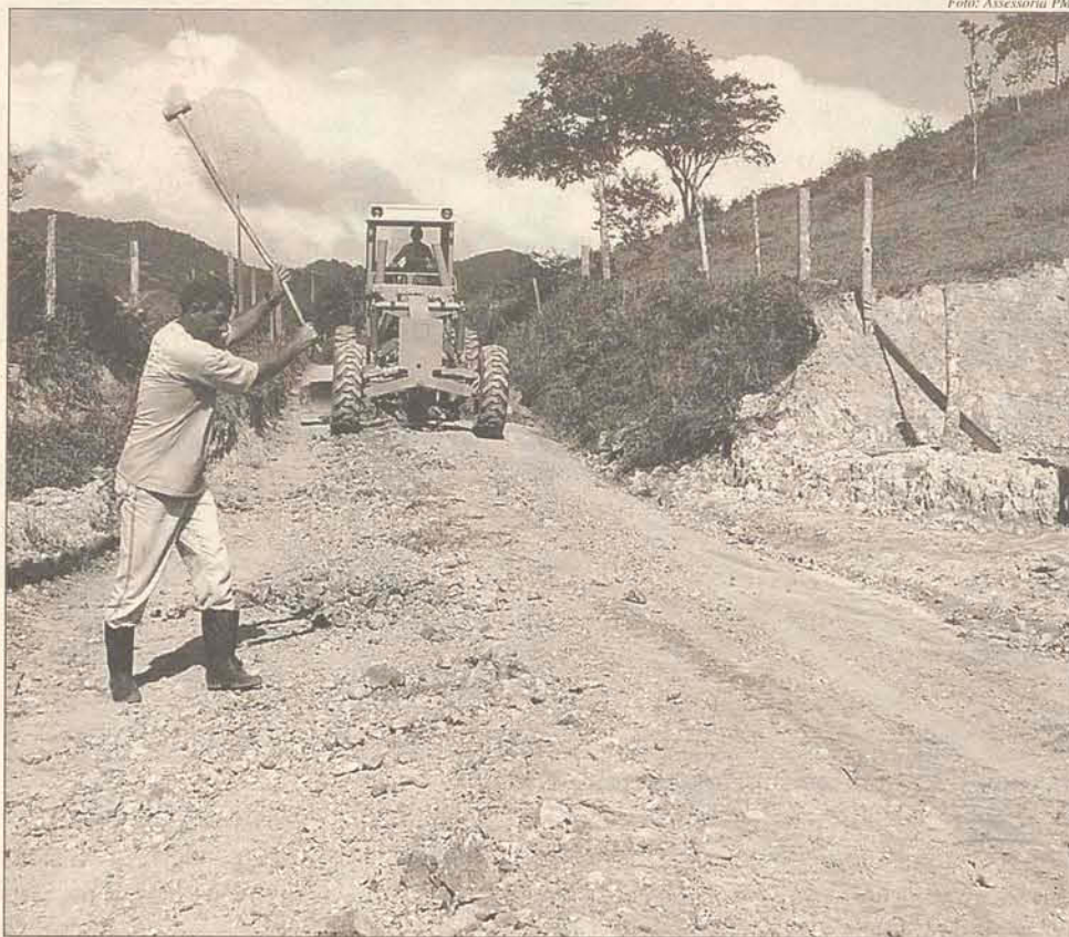
Mil metros cúbicos de macadame devem ser usados na recuperação das ruas
