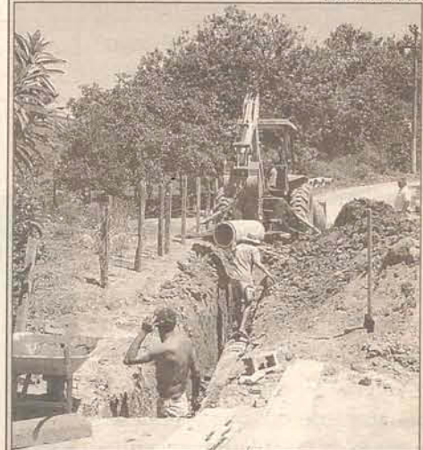
Tubos foram colocados na Isidro Vieira
