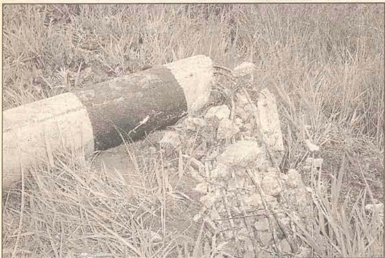
Impacto foi tão forte que arrancou o poste do chão
