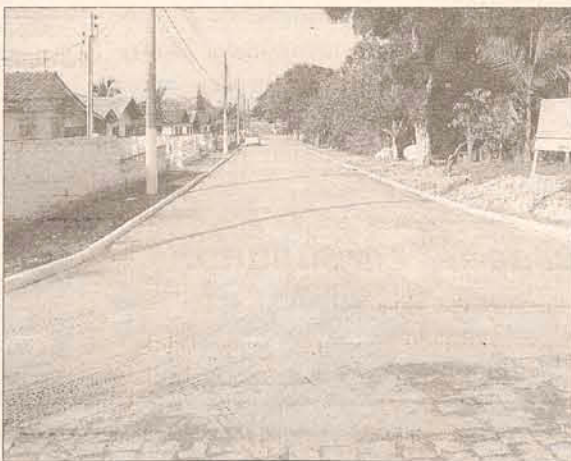
Moradores são beneficiados com pavimentação
