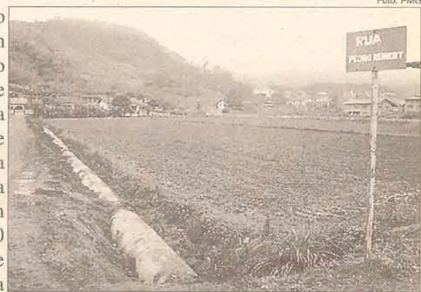
Novos tubos foram instalados no Belchior Central
