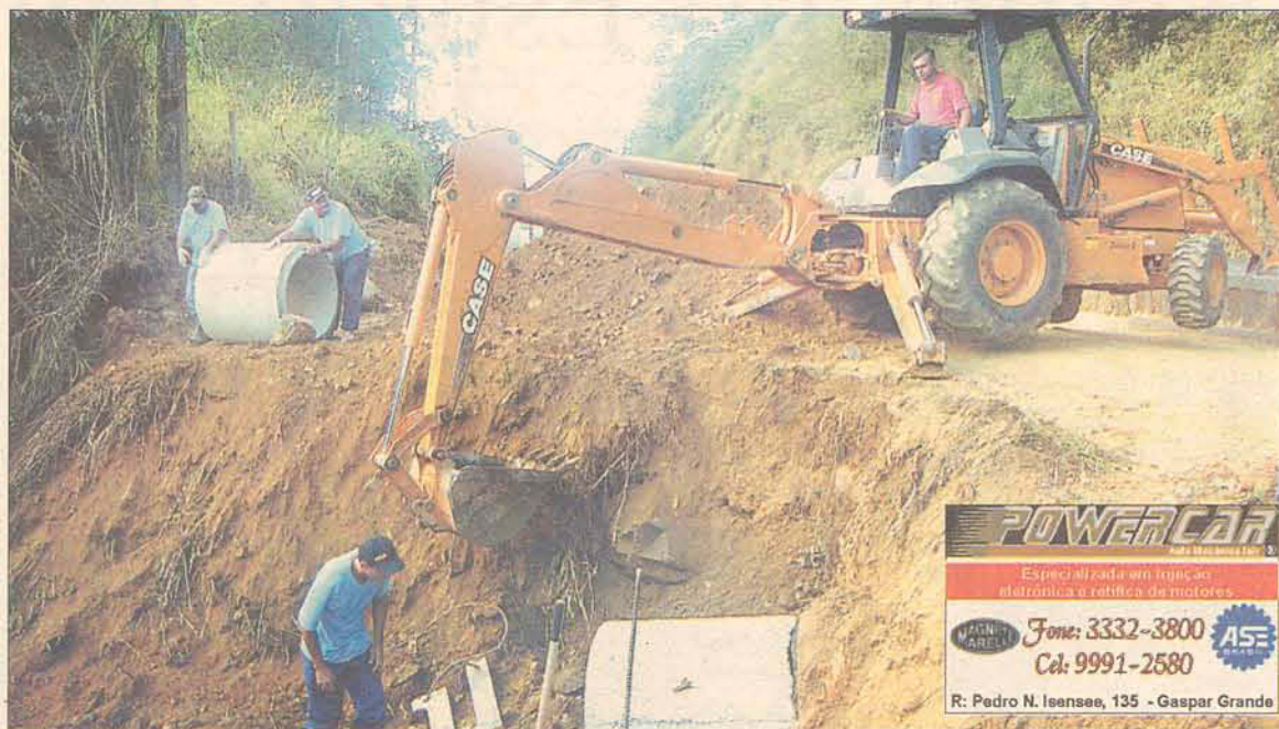
Máquinas e operários da prefeitura trabalham no alargamento da rua
