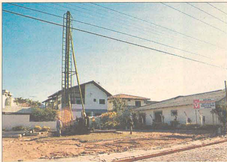
Fundamento da sede própria da Rede já esta pronto
