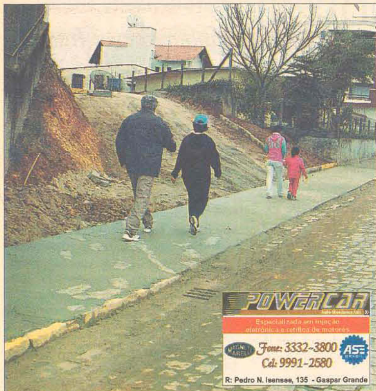
Local oferecia risco aos pedestres
